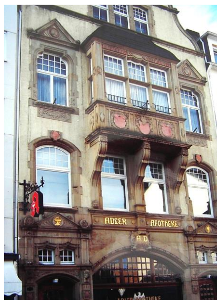
„Stützpunkt“ in der Telegrafstraße in Bad Neuenahr
